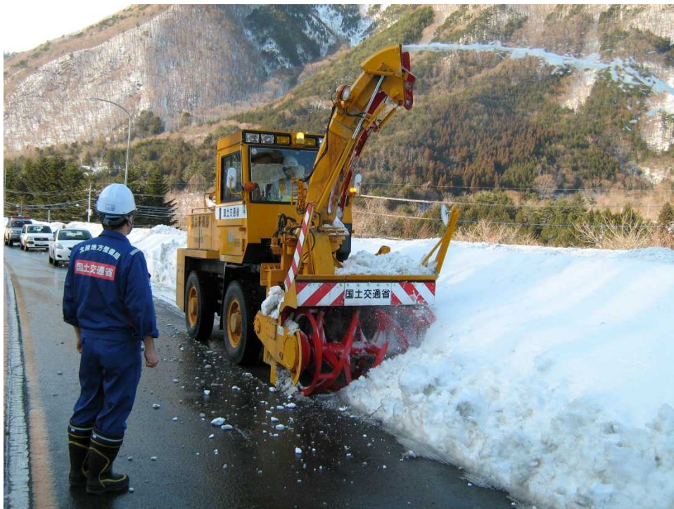
除雪場所：県道 23 号（山梨県北杜市須玉町比志地先）
