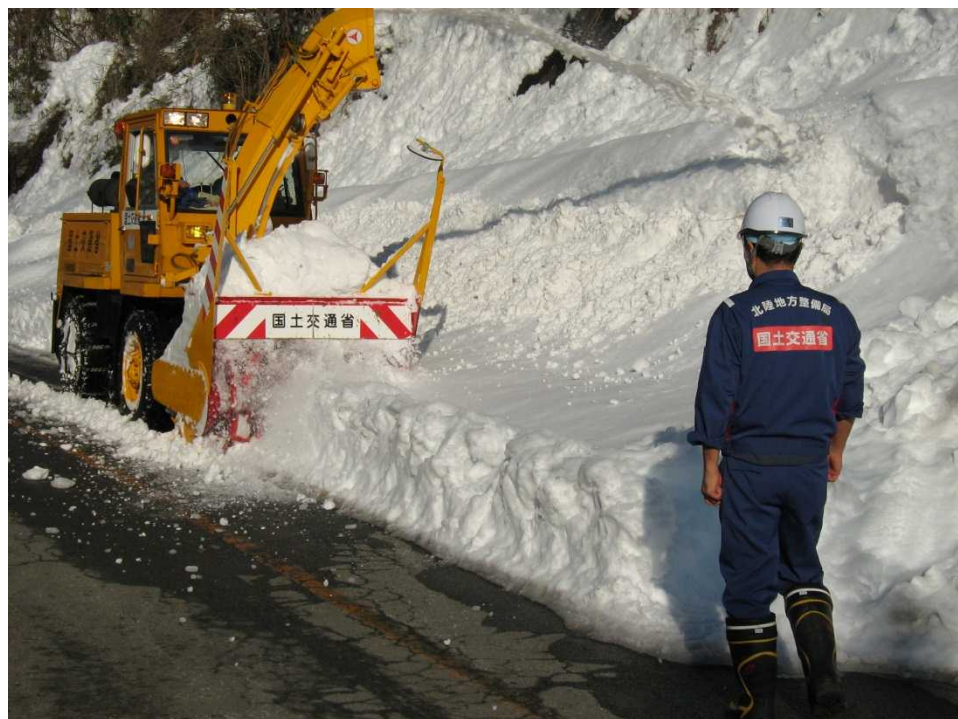
除雪場所：国道 140 号（山梨県甲州市川浦地先）
