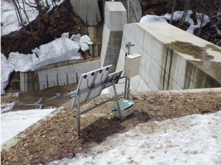
下祝沢左岸から右岸方向(地すべり地方向)を望む位置に設置しました
