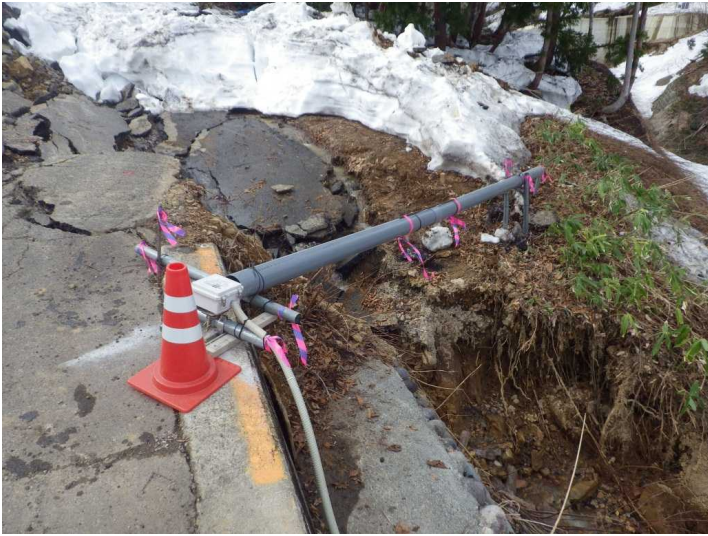
下流から上流方向を望む
