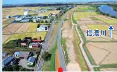
築堤 (平成20年9月撮影)
