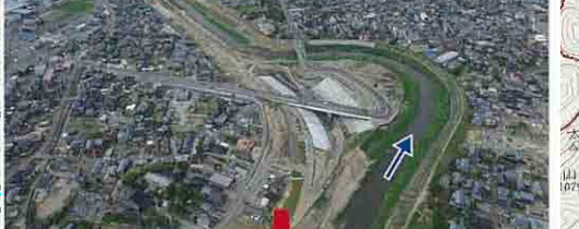
河道付替・築堤 (平成21年6月撮影)
