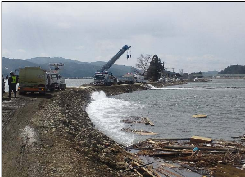
宮城県北上川大橋下流での津波による内水排水 (排水ポンプ車60m 3 /mmによる排水作業)
