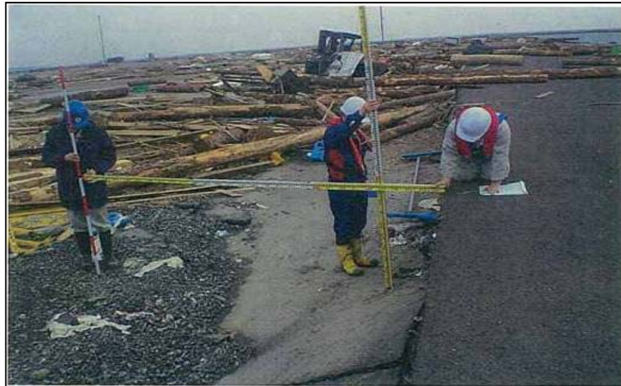
3/14 現地調査班(港湾班)活動状況 宮城県石巻港の港湾施設の被災状況
