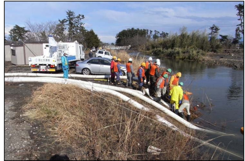
津波によるゴミ等の除去を行いながらの 排水作業を実施中
