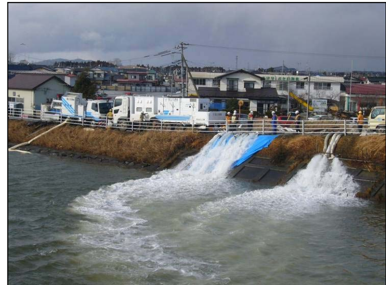
宮城県北上川淀川橋上流での津波による内水排水 (排水ポンプ車60m 3 /mmによる排水作業)
