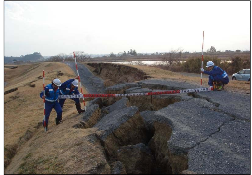
3/14 現地調査班(河川班)活動状況 宮城県鳴瀬川堤防の被災状況調査
