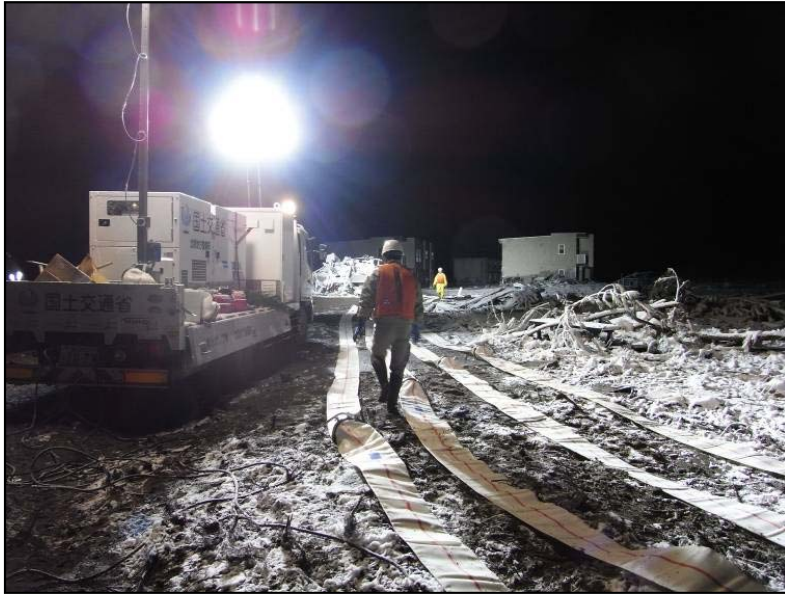
宮城県名取川での津波による内水排水 (排水ポンプ車30m 3 /mm及び照明車を利用し、 夜間も排水作業を実施)
