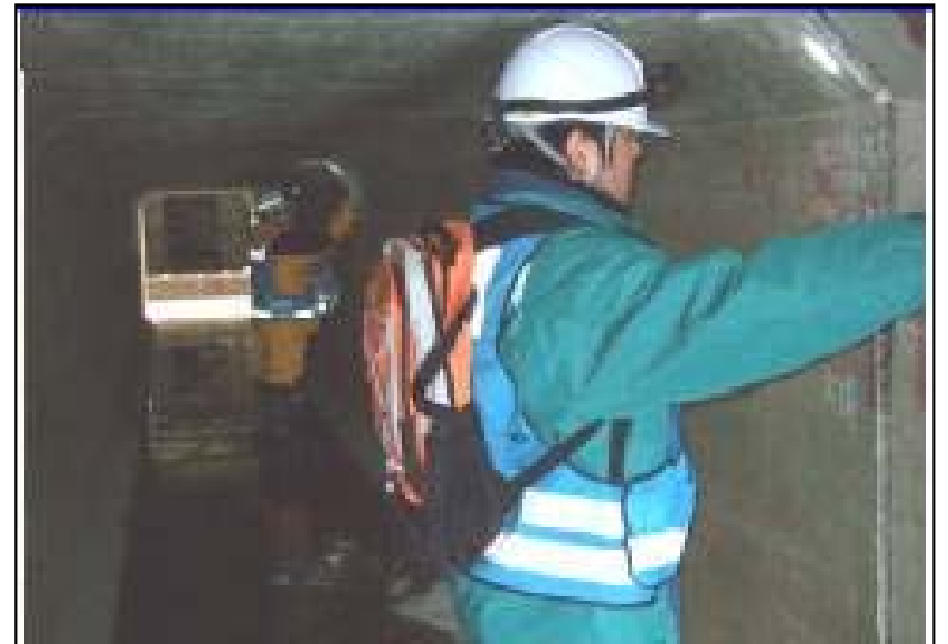
3/23 現地調査班(河川班)活動状況 樋管(BOXカルバート)の点検
