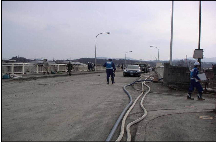
3/14 現地調査班(道路班)活動状況 気仙沼大橋被災状況調査
