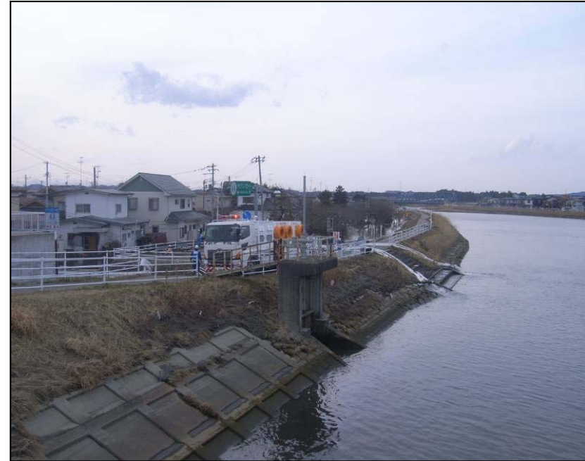
3/14 応急対策班(排水ポンプ車)活動状況 宮城県名取川下流左岸(排水ポンプ車60m 3 /mm)
