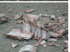
地の陣棟瓦落下
