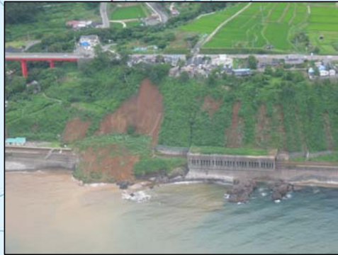
砂防 柏崎市青海川(おうみがわ) がけ崩れ H=40m W=70m
