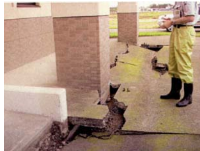
上越市柿崎浄化センター 地盤沈下
