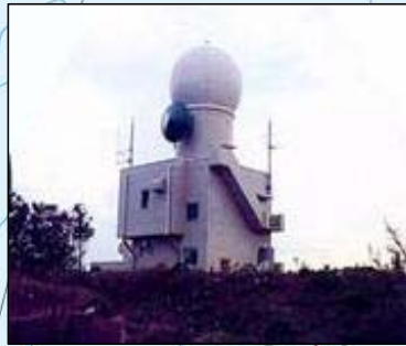
薬師岳レーダー雨雪量観測所(長岡市宮本) 設備障害により観測停止。復旧作業中
