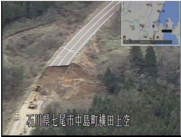
被災地視察状況(能登有料道路) 北陸地整防災ヘリ「ほくりく号」より)
