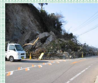
(一)深谷中浜線 崖崩れで片交 (志賀町酒見)
