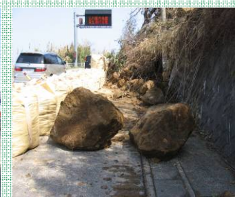
国道249号 落石で片交 (輪島市大野)
