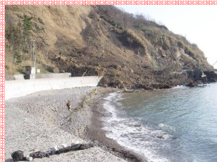
深見漁港付近の市道における大規模崩落で交通が完全に寸断(自転車隊調査)
