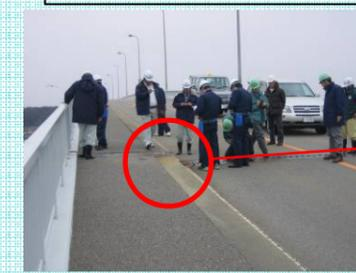
橋面のジョイント部が損傷
