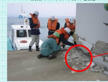
橋脚の基部が損傷
