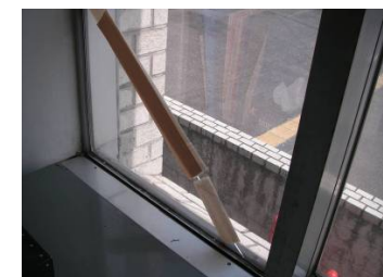
ガラス亀裂補修
