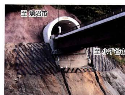
トンネル坑口部分の法面对策状況 平成18年10月20日撮影
