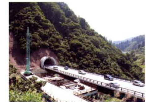
式典終了後の山古志トンネル利用状況
