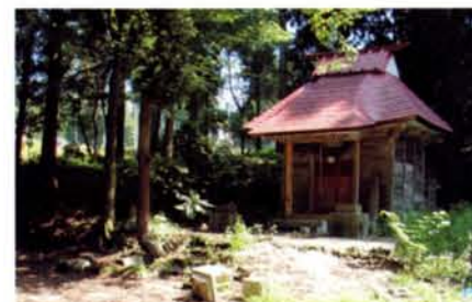
地震の被害が残る梶金集落の十二神社
