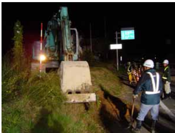
国道17号 川口町天納 迂回路の応急工事 (H16.10.24 撮影)
