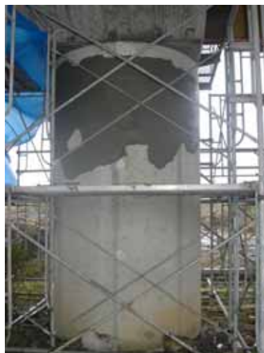
国道8号 新組跨線橋 コンクリート巻立て (H16.10.25 撮影)
