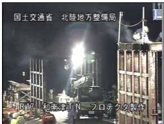
国道17号 和南津トンネル 夜を徹しての復旧作業 (H16.10.27 撮影)
