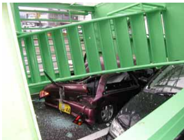
小千谷市桜町 倒壊した非常階段 (H16.10.25 撮影)
