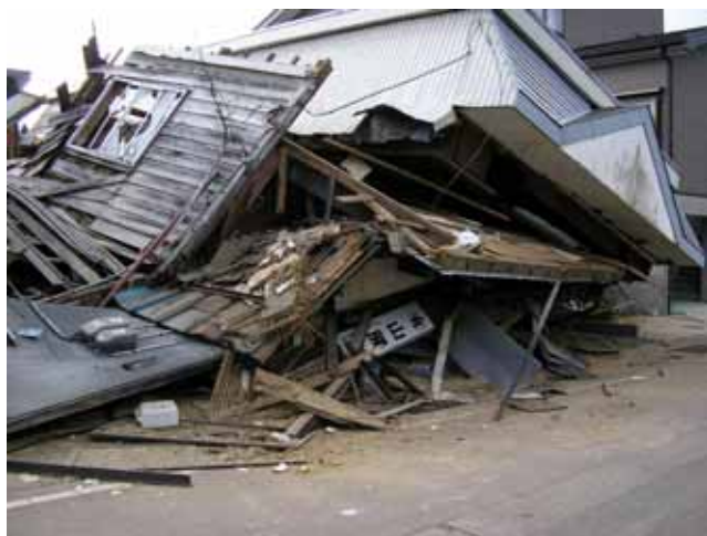
越後川口駅前 倒壊した家屋 (H16.10.25 撮影)
