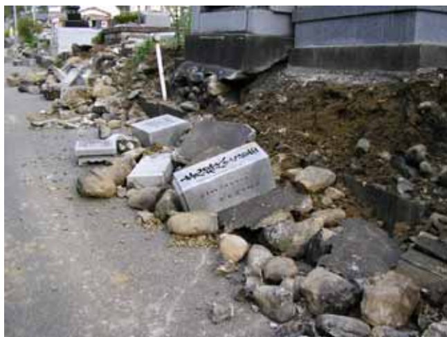
越後川口駅前 倒壊した墓石 (H16.10.25 撮影)
