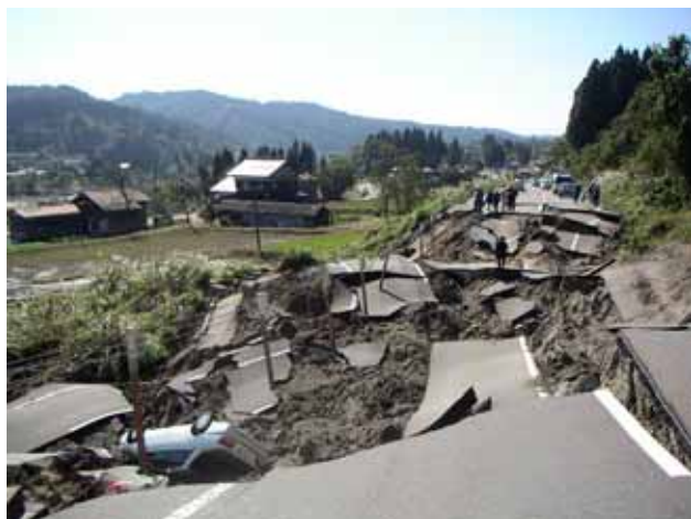
国道117号川口町 破壊された幹線道路 (H16.10.24 撮影)
