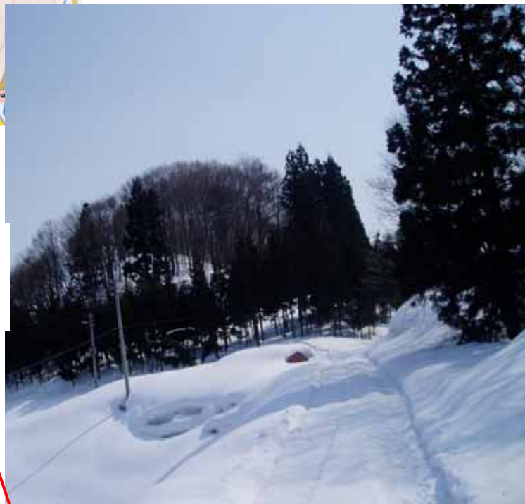
除雪前の工事用道路(3月10日撮影) 3m近い積雪があります
