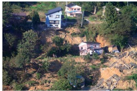
土砂崩れによる家屋倒壊
