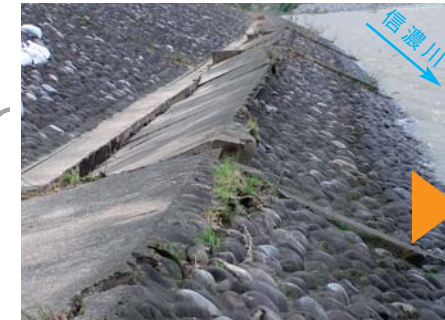
⑤ 十日町市城之古護岸損壊 信濃川右岸城之古地先の護岸小段で70mに渡り陥没
