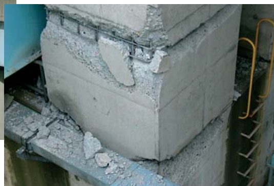
コンクリートが破損し、鉄筋が露出した妙見堰第8堰柱
