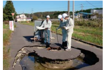
下水道の被災状況把握のための概略調査状況(出雲崎町)
