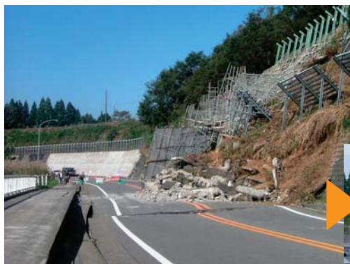
③ R17川口町牛ヶ島 斜面崩落 山側斜面が崩れ落ち車道がふさがれる。
