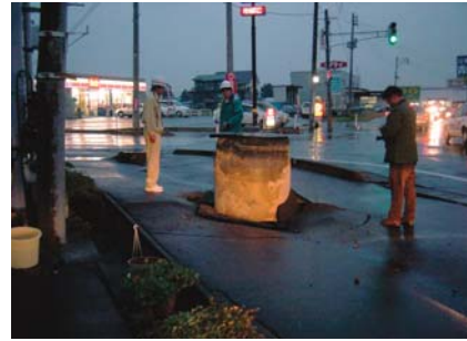
① 地盤の液状化により突出した下水道のマンホール(小千谷市内)
