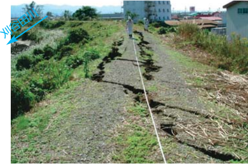
④ 中之島町五百刈堤防天端亀裂(県管理河川) 信濃川右支川刈谷田川左岸の堤防天端に亀裂
