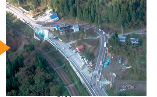
④ R17川口町天納 迂回路設置 復旧に長期間を要すると判断されたことから、緊急に迂回路を設置し10月31日22時30分に2車線で交通確保。
