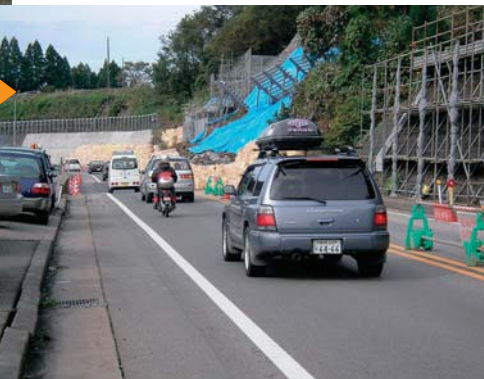
③ R17川口町牛ヶ島 斜面崩落 山側斜面が崩れ落ち車道がふさがれる。
