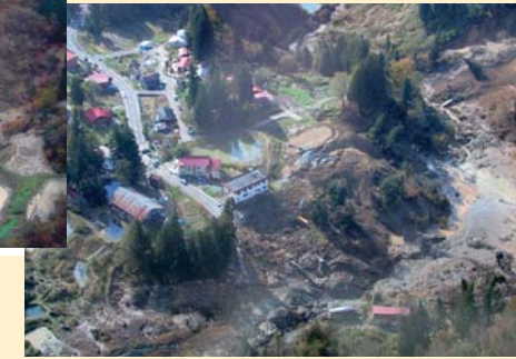
③山古志村東竹沢 橋があった箇所が完全に寸断された。
