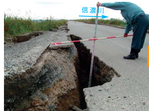
① 越路町岩野仲島堤防天端亀裂 信濃川右岸岩野仲島地先の堤防天端で1,600mに渡り、大きな亀裂が発生
