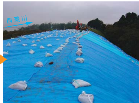
② 長岡市三俵野緊急復旧完了 降雨に備え、崩壊箇所を掘削、盛土、シート張りによる緊急復旧を実施(10/25 24:00完了)
