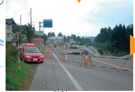
④ R17川口町天納 緊急通路確保 緊急時及び生活道路を確保するための緊急通路(1車線)を10月25日1時に確保。
