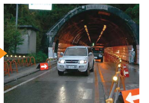
⑤ R17号川口町和南津 トンネル応急復旧 新たな支保工(H鋼)設置とコンクリート吹付けを行い、11月2日16時20分に片側交互通行で交通を確保。
