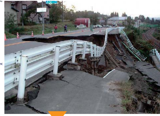
④ R17川口町天納 道路破壊 谷側斜面の崩落によりJRとともに道路が崩壊。
