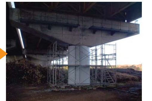
② R8長岡市新組 橋脚補強 炭素繊維巻付け補強により応急復旧を行い、10月30日6時5分に全面規制解除。
