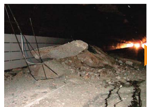
⑤ R17号川口町和南津 トンネル損壊 和南津トンネルで覆工コンクリートの崩落、剥離等の損傷が発生。
