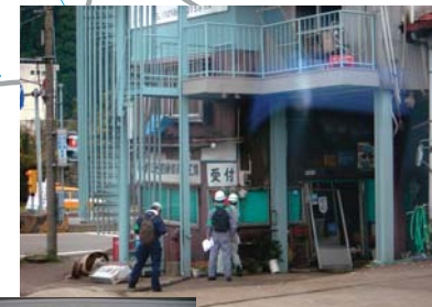
被災建築物の応急危険度を判定(川口町)余震によって黄(要注意)が赤(危険)となる建築物がある。
