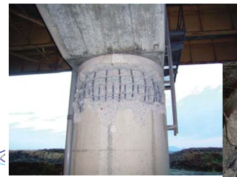
② R8長岡市新組 橋脚損壊 新組跨線橋下り線の橋脚上部のコンクリートが剥離し鉄筋が露出するなどの破損。
