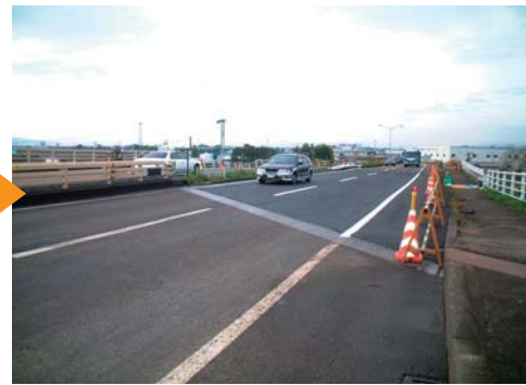
① R8中之島町灰島新田 段差すり付け アスファルト舗装によるすり付けを行い、10月30日17時に全面規制解除。
