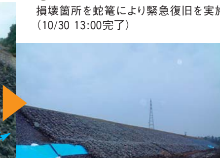
⑥ 十日町市高島緊急復旧完了 蛇管、シート張りによる緊急復旧を実施(10/30 13:00完了)
