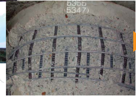
② R8長岡市新組 橋脚損壊 新組跨線橋下り線の橋脚上部のコンクリートが剥離し鉄筋が露出するなどの破損。
