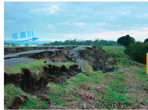
② 長岡市三俵野堤防裏法崩れ 信濃川右岸三俵野地先で150mに渡る裏法崩壊が発生
