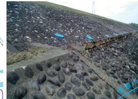
⑥ 十日町市高島護岸損壊 信濃川左岸高島地先の護岸で70mに渡り損壊
