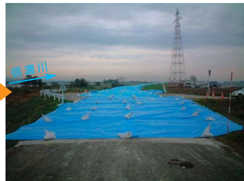
① 越路町岩野仲島緊急復旧完了 亀裂の発生箇所を掘削、盛土、シート張りによる緊急復旧を実施(10/29 21:00完了)
