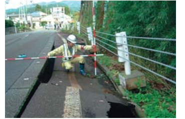
市町村道の災害状況緊急調査(小千谷市三仏生)
