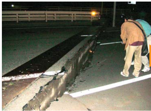
① R8中之島町灰島新田 路面段差 見附大橋のたもと道路が沈下し段差が生じた。
