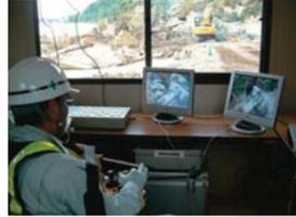
遠隔操縦式バックホウの操作
