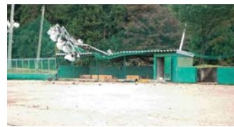
倒壊した野球場の照明塔(川口町)
