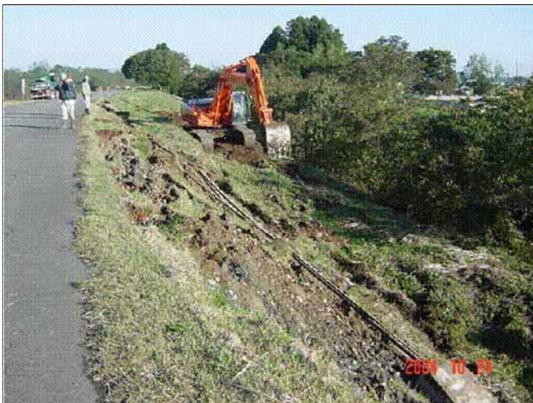
応急復旧状況(盛土工、シート張工実施中) 24 日午後 1 時頃
