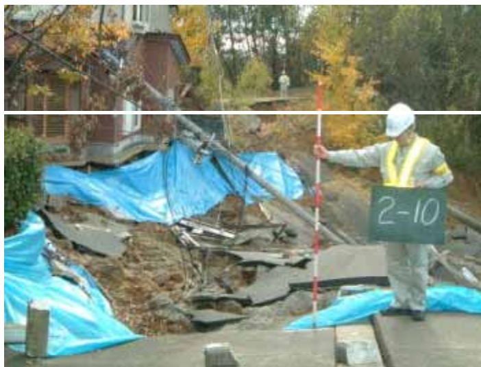
長岡市高町（市道山通132）における作業状況
