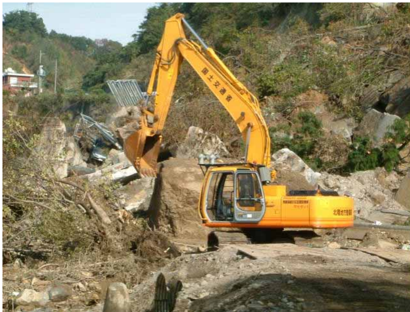
遠隔操縦式バックホウによる仮設道路整備
