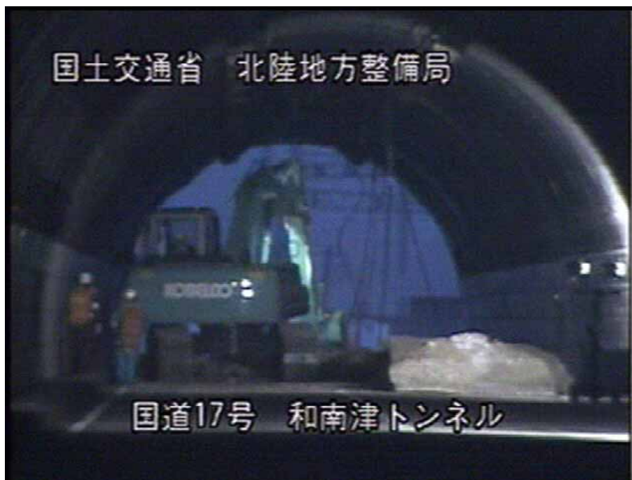
配信画像（国道17号 和南津トンネル）
