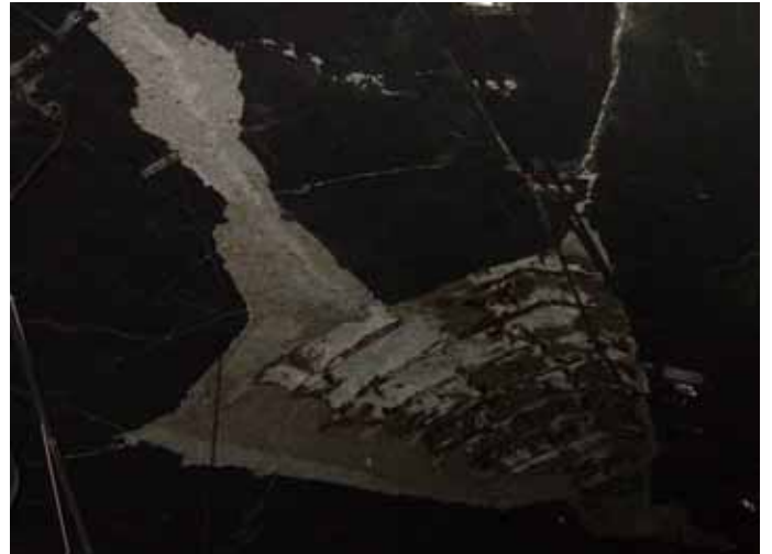
トンネル巻き立てコンクリートのクラック、及び剥離した状況
