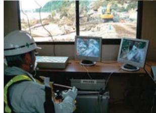
遠隔操縦式バックホウの操作
