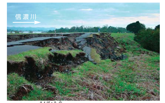
② 長岡市三俣野堤防裏法崩れ 信濃川右岸三俣野地先で150mに渡る裏法崩壊が発生
