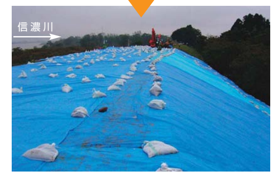
② 長岡市三俣野緊急復旧完了 降雨に備え、崩壊箇所を掘削、盛土、シート張りによる緊急復旧を実施(10月25日24時完了)
