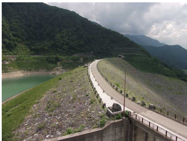
ダム堤体の様子(管理所屋上より)
