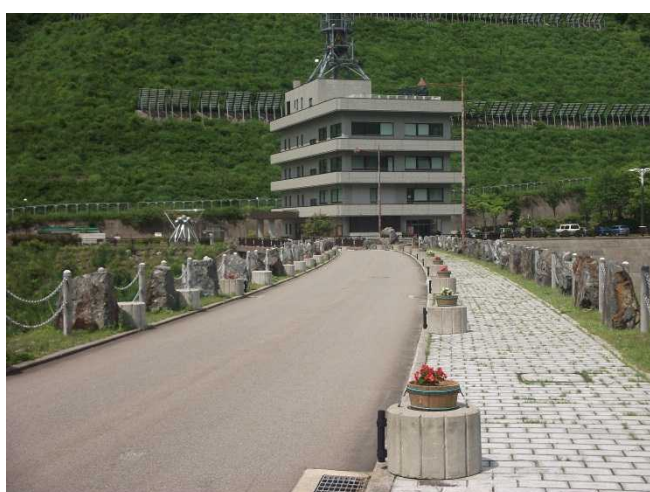
ダム天端の様子(ダム天端より)
