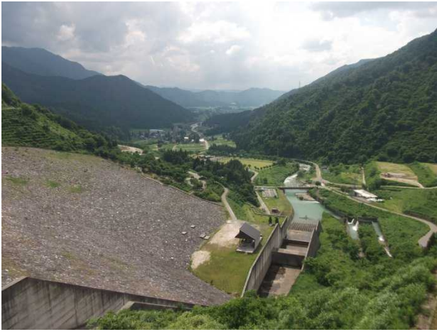
ダム下流の様子(管理所屋上より)
