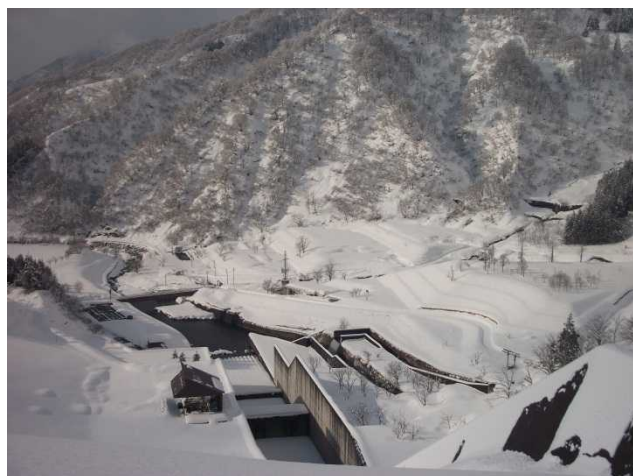
ダム放流口の様子(堤体より)
