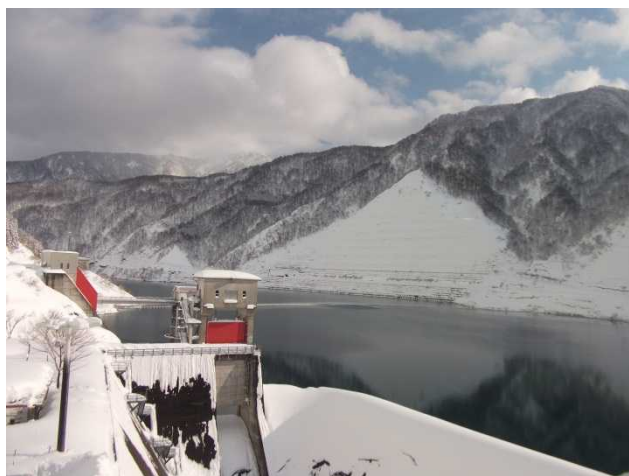
ダム湖の様子(管理所屋上より)
