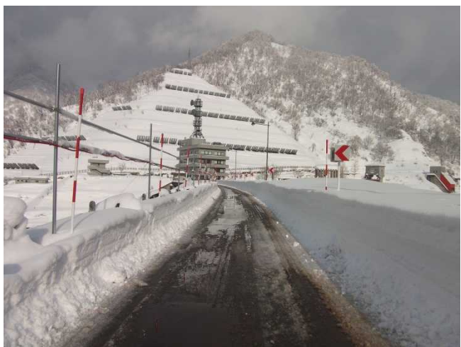
ダム堤体の様子(堤体左岸側より)
