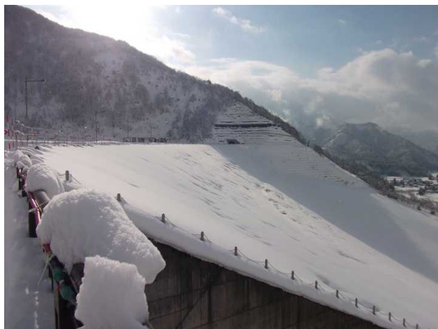
堤体下流側の様子(堤体右岸側より)
