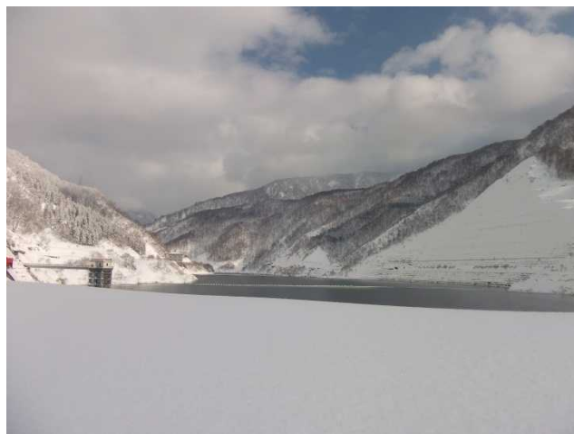
ダム湖上流の様子(堤体より)
