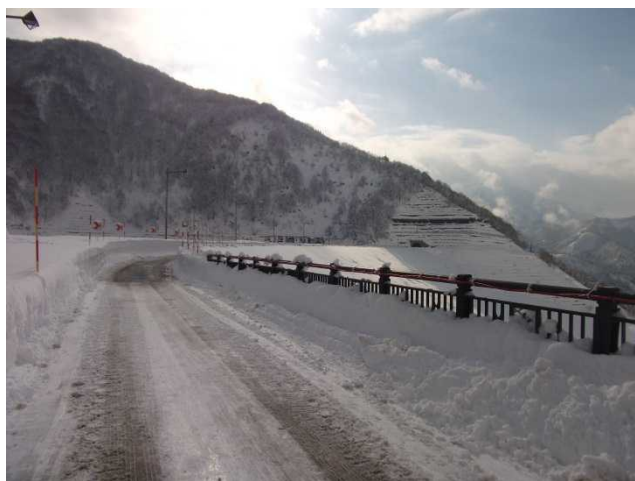
ダム天端の様子(堤体右岸側より)
