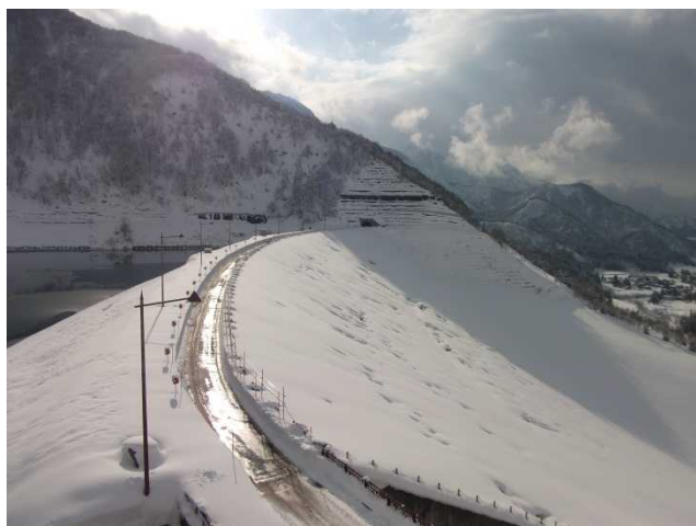
ダム堤体の様子(管理所屋上より)
