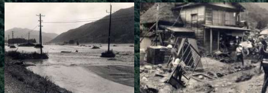
【昭和 44 年洪水 被害状況】 死者 2 名 重傷者 4 名 建物被害 3300 戸 被害総額 42 億円
