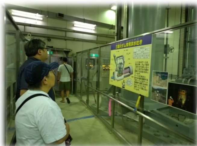
常用洪水吐ゲート室
