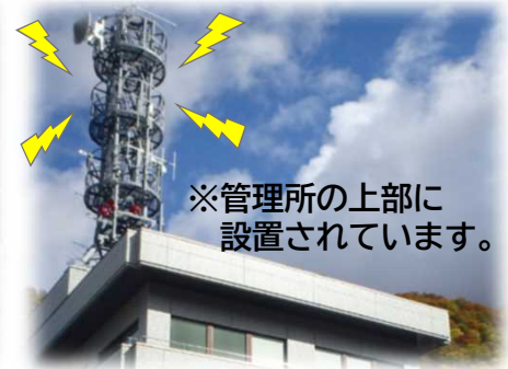
【 警報試験で使用したサイレン 】
