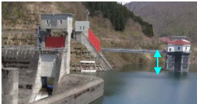
貯水位(標高) 427EL.mの様子
