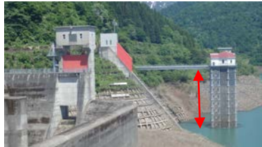
貯水位(標高)399.5EL.mの様子
