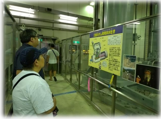
常用洪水吐ゲート室
