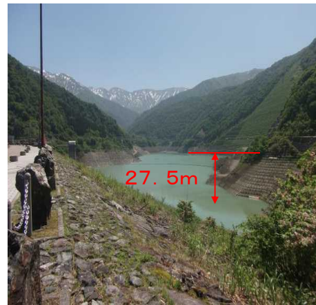
現在のダム湖 貯水位399.5m （洪水貯留準備水位）
