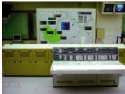
現ダムコン操作卓は窓際？(写真中央向こう側)へ仮移設完了 手前が新ダムコン操作卓 (平成17年12月工事中)
