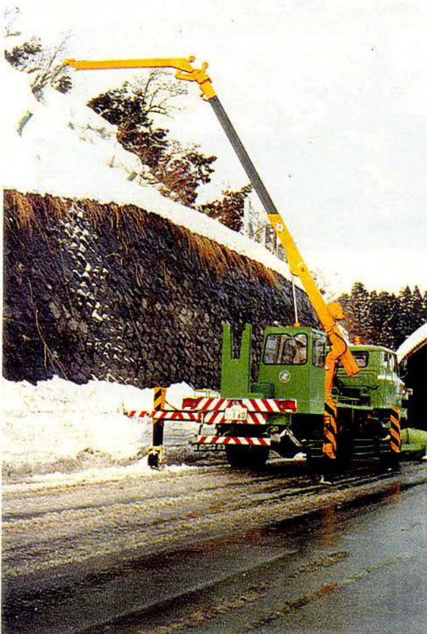
高所の雪庇処理作業
