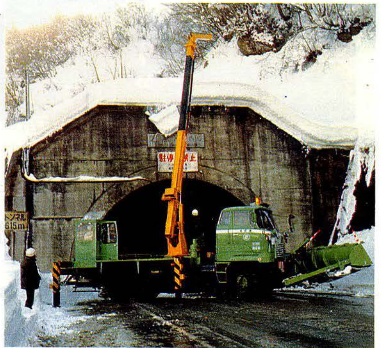
トンネル坑口の雪庇処理作業
