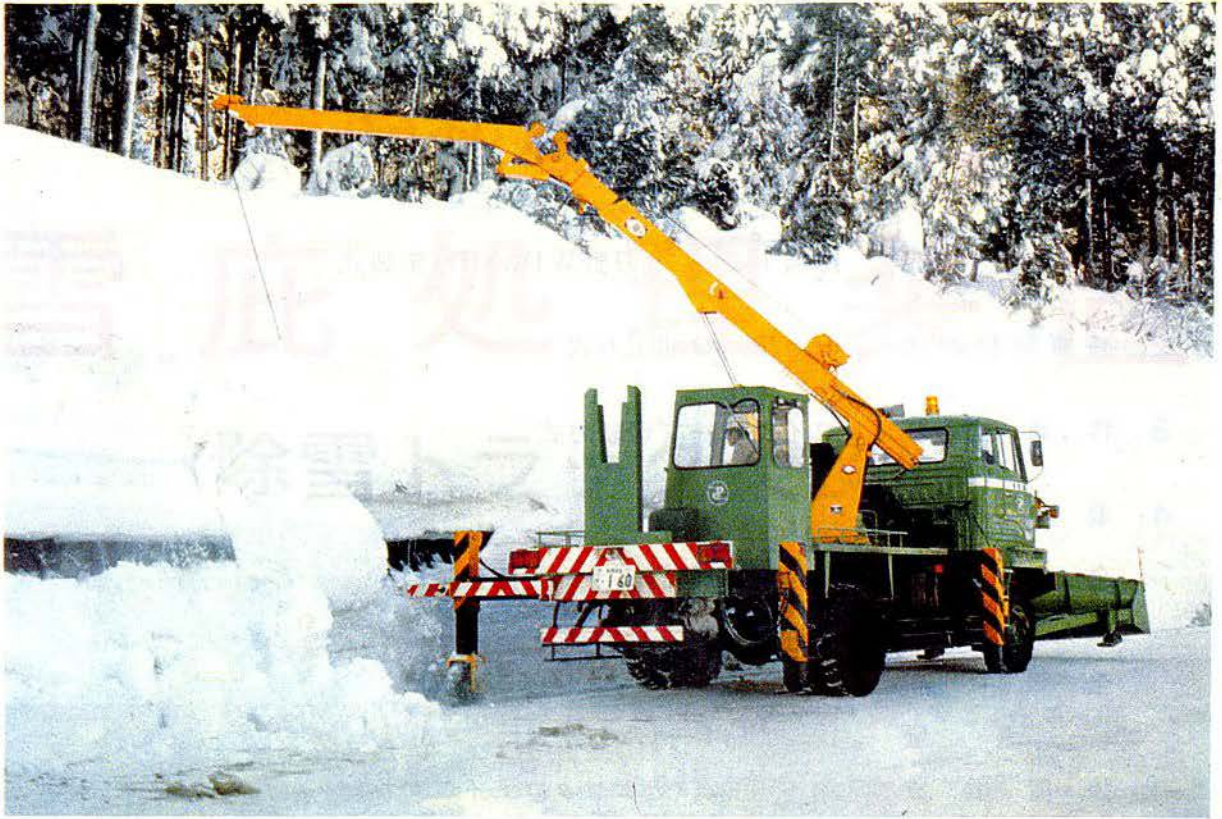
雪庇処理作業状況
