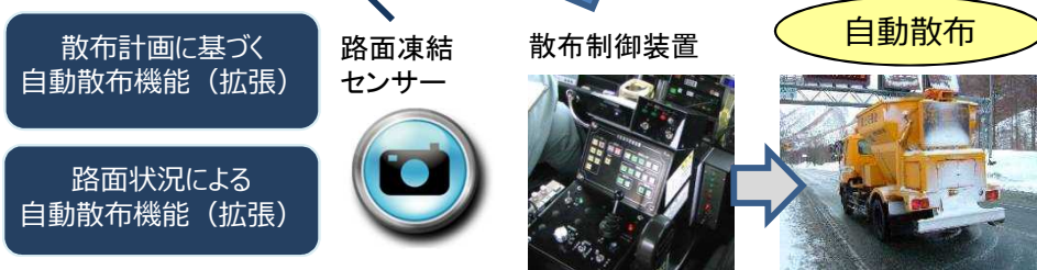
自動散布操作装置全体構成
