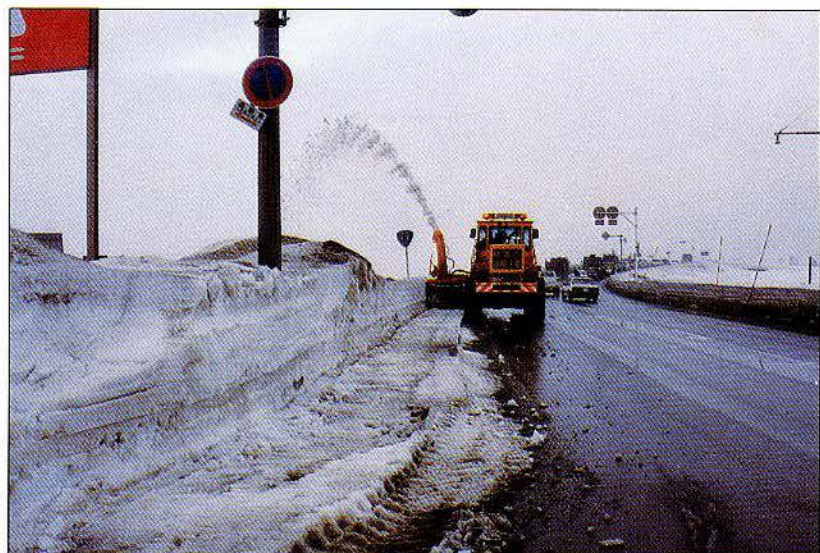
歩道除雪作業 (マウンドアップ箇所)
