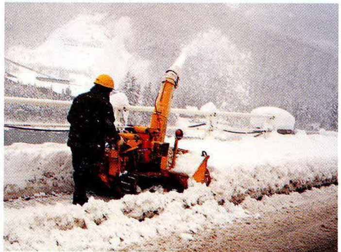
歩道除雪状況
