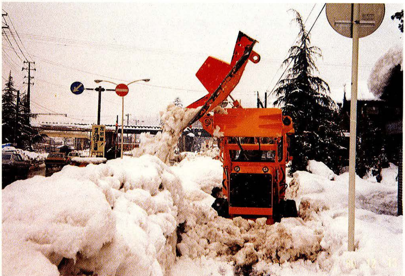
サイドダンプによる歩道除雪
