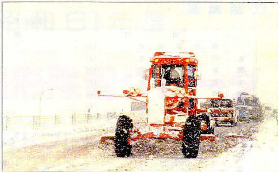
路面整正 単独作業
