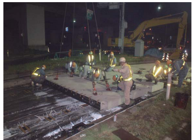
④プレキャスト舗装版施工状況
