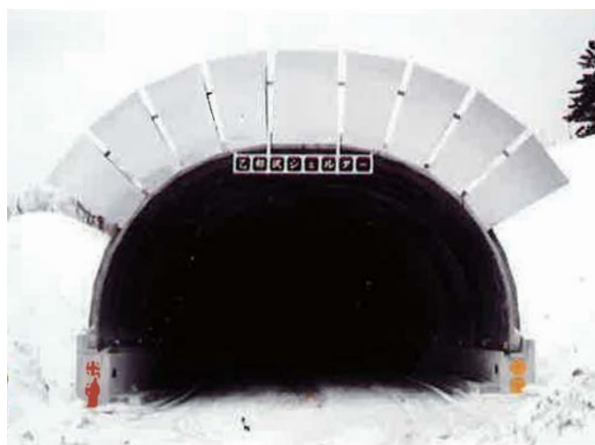
③雪庇予防柵を備えたシェルター
