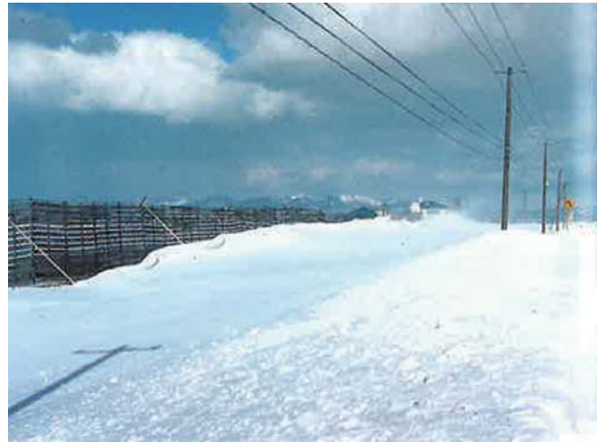
②柵による吹溜り状況
