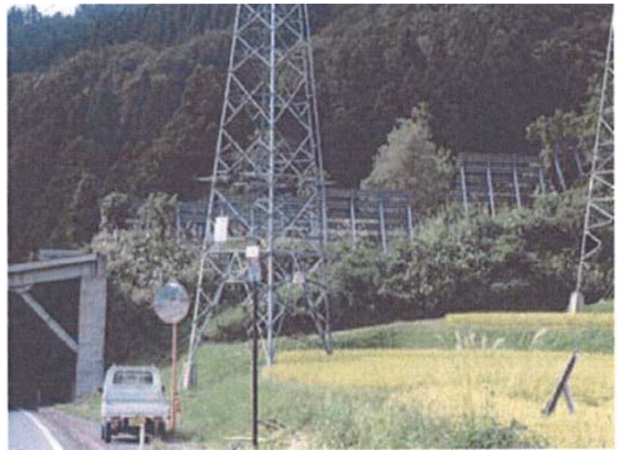
②誘導工（誘導柵）
