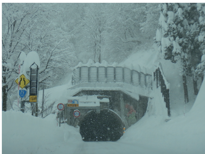
①トンネルとせり出し防止柵
