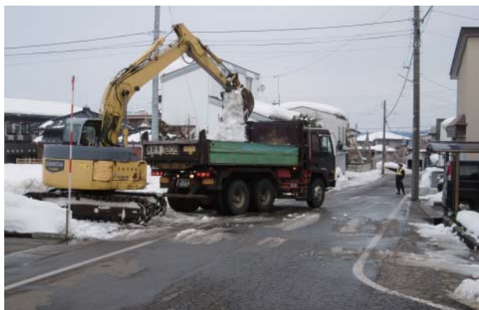
バックホウによる積み込み作業
