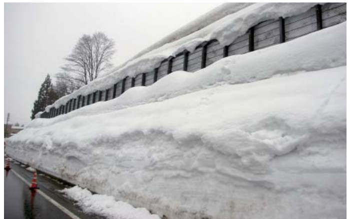
雪庇・雪堤状況
