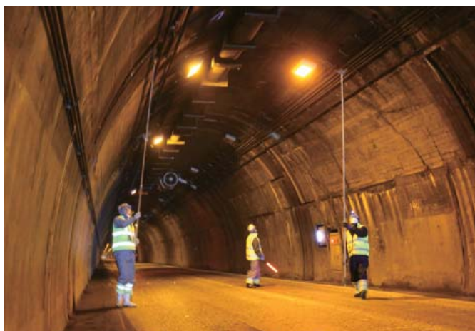
トンネルのつらら落とし
