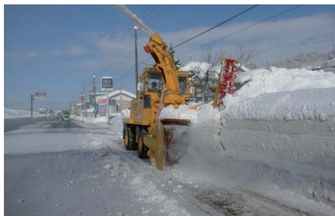
ロータリ除雪車による作業
