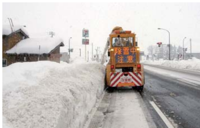
ロータリ除雪車による作業（拡幅後）
