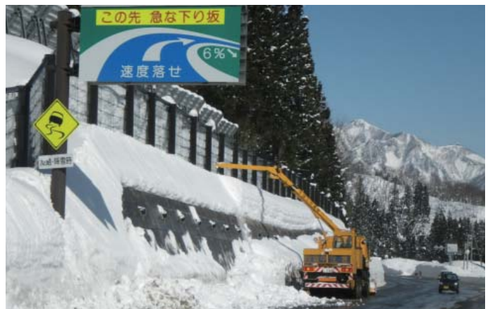
雪庇処理車による作業
