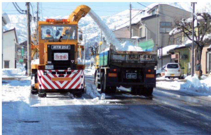
ロータリ除雪車による積み込み作業
