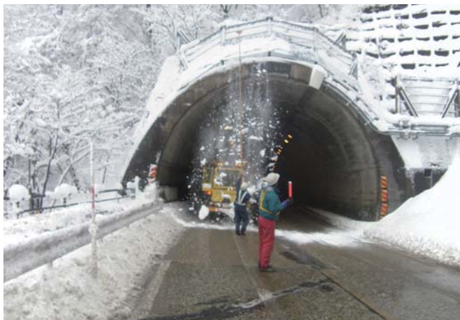
トンネル坑口の雪落とし
