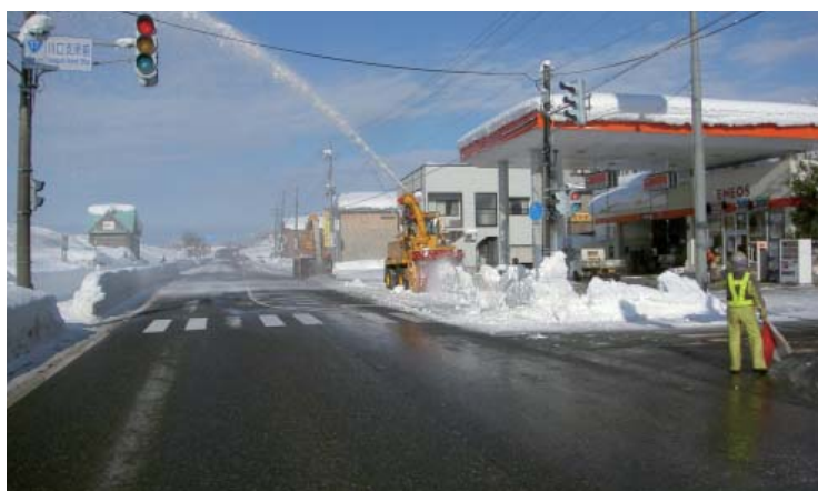
ロータリ除雪車による作業
