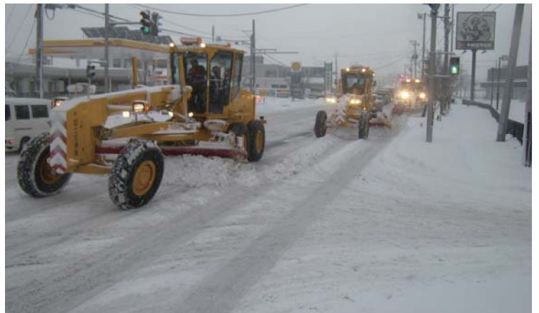
除雪グレーダによる梯団作業
