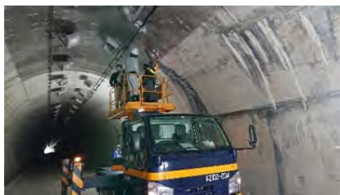
現地実習（トンネル初級研修）
