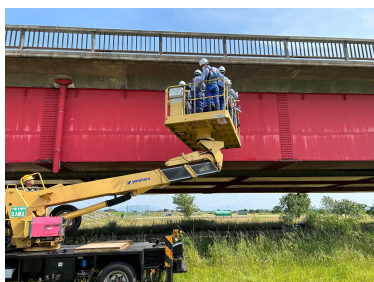
現地実習（橋梁初級Ⅰ研修）
