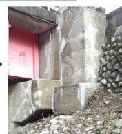
〈ひび割れ補修〉
