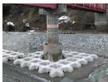
〈根固めブロック設置〉
