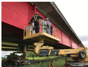
現地実習（橋梁初級Ⅰ研修） 令和4年度：東部
