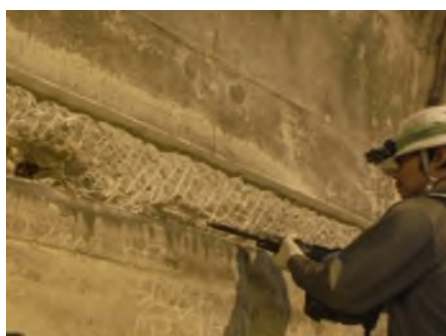
断面修復補修
