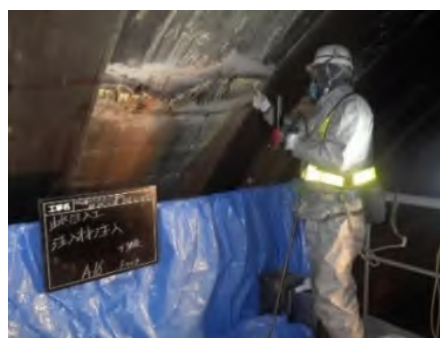
ひびわれ注入補修
