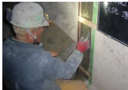
断面修復補修
