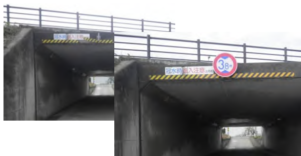
変形部材の更新等
